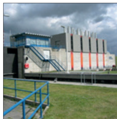
Spuisluis Nieuwe Statenzijl
