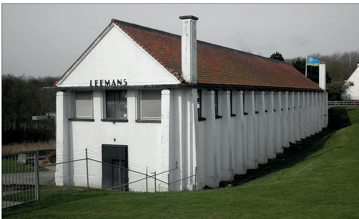
Gemaal Leemans. Pompt water uit de Wieringermeer naar de Waddenzee
