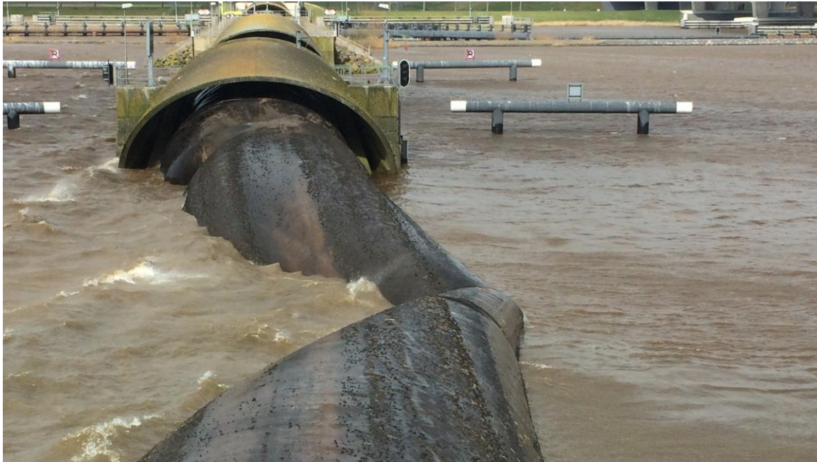
Afbeelding IX.2 Foto van opgeblazen balgstuw Ramspol (foto uit 2015. bron: NOS.nl)
