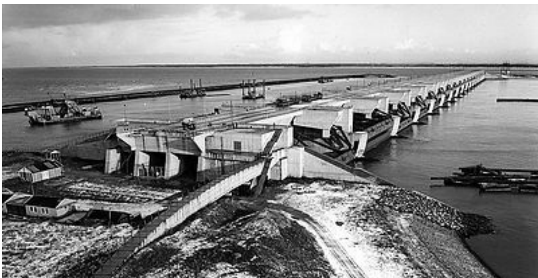
Figuur 4.1 Haringvlietsluizen in aanbouw: overzichtsfoto van de bouwput na inundatie. In november 1958 is met de aanleg begonnen en in 1971 was de aanleg voltooid. Foto uit archief van Rijkswaterstaat: http://www.deltawerken.com/De-sluizen/202.html
