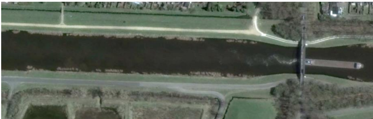
Figuur 25 Erosie t.g.v. retourstromen en/of schroefstromen in de zijtak van de Twentekanal
