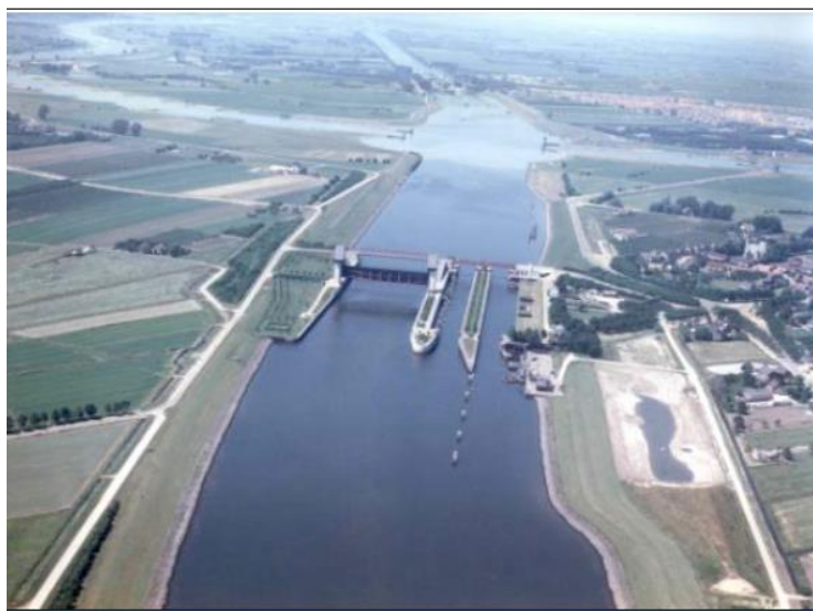
Foto 2 Luchtfoto Marijkesluizen en kering Ravenswaaij
